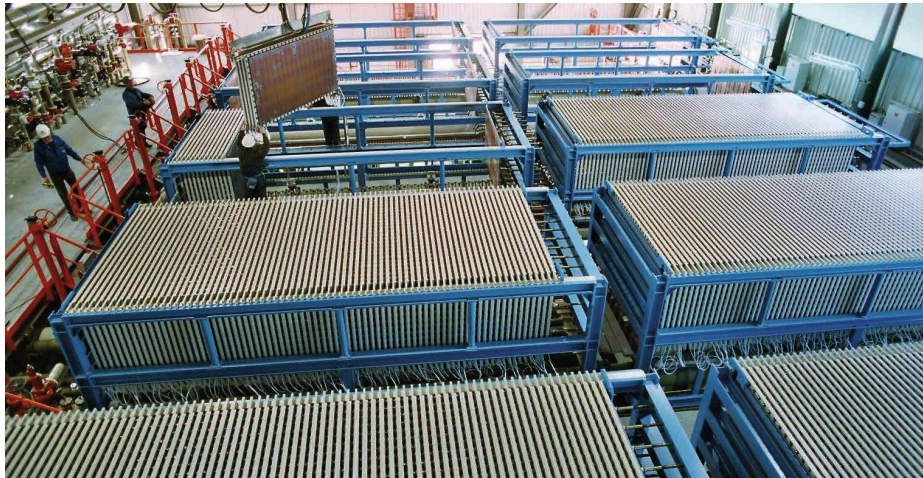
Montage der Module eines bipolaren Uhde BM 2.7 Elektrolysierrahmen
